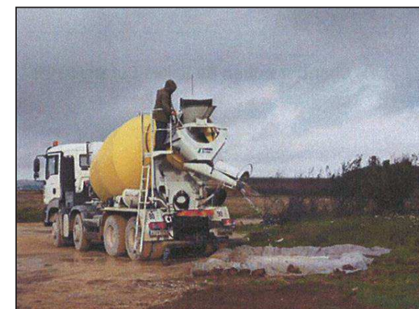
Illustration 416 : Utilisation d'un géotextile filtrant pour le lavage des camions-toupies
